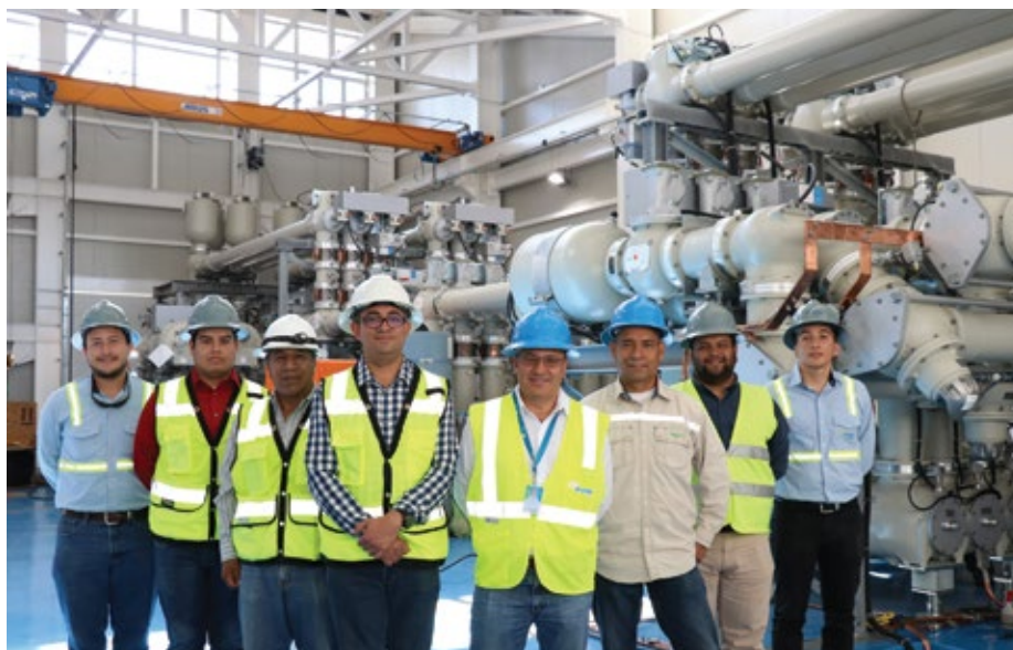
Subestación Inciense 230 kV
