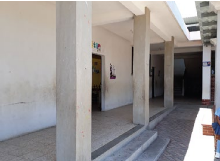
Fachada de escuela - Antes
