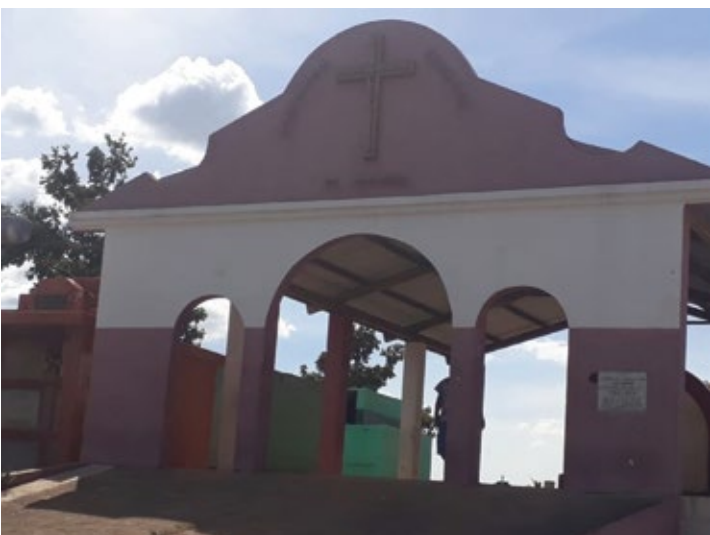
Infraestructura comunitaria - Antes
